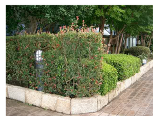
外構（植栽）工事
