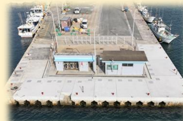
鐘崎漁港2号岸壁での耐震耐津波対策工事
