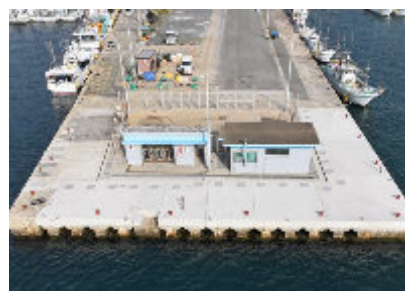
鐘崎漁港での 耐震耐津波対策工事
