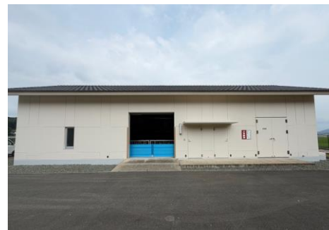
浸水に備え耐水化した田島汚水中継ポンプ場
