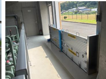
浸水に備え耐水化した田島汚水中継ポンプ場
