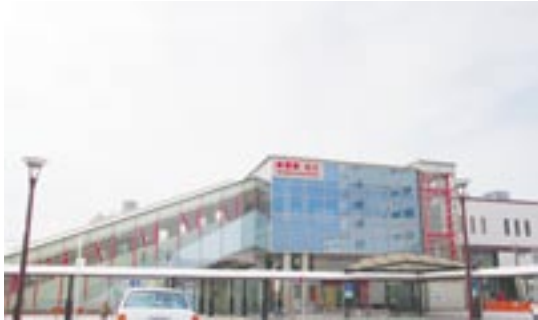
平成21年にリニューアルした赤間駅北口
