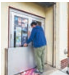
▲入口ドア前に設置する着脱式の止水板
