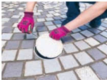
ますの蓋はマイナスドライバーで外せます
