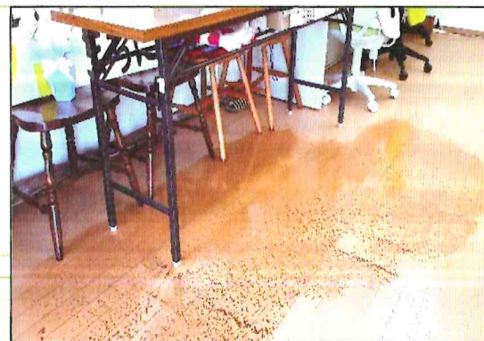
床上浸水した市民ネットの事務所
