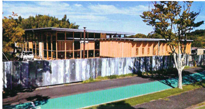
ユリックス南側ゾーンで全天候型こども遊び場施設建設が進んでいる
