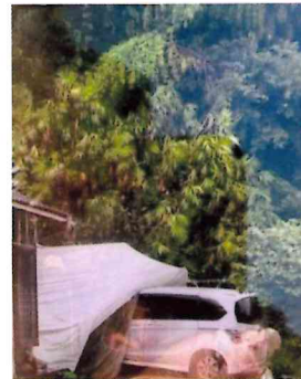
田野土砂崩れ、車庫に土砂流入
