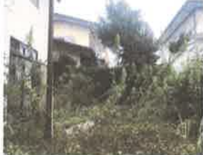
空き家の雑草や雑木が周辺住居まで繁茂している状況の事例
