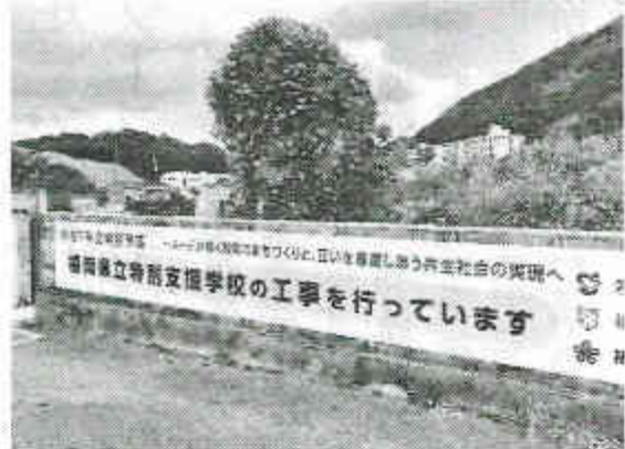
特別支援学校の造成工事が進められています
