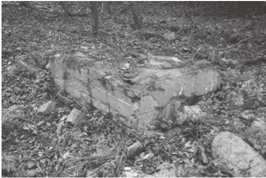
図11 セメント練箱跡
