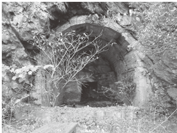
写真 4 鶴見崎第一砲台 砲座 1
