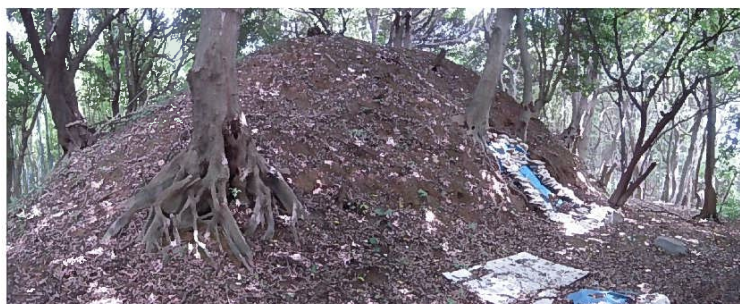
(写真 II-14 崩壊する墳丘)、(墳丘北側から)
