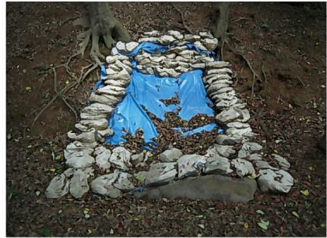
(写真Ⅱ-15 土嚢積みによる仮密閉される開口部)
