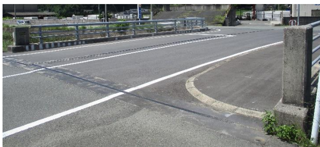
修繕実績(太郎坊橋)
