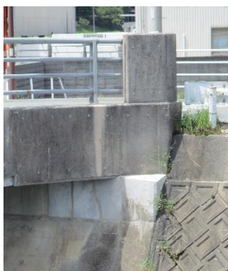
修繕実績(太郎坊橋)
