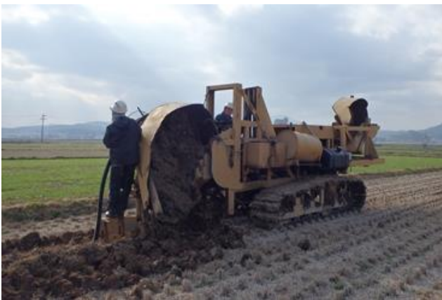
暗渠排水設備の新設・更新工事
