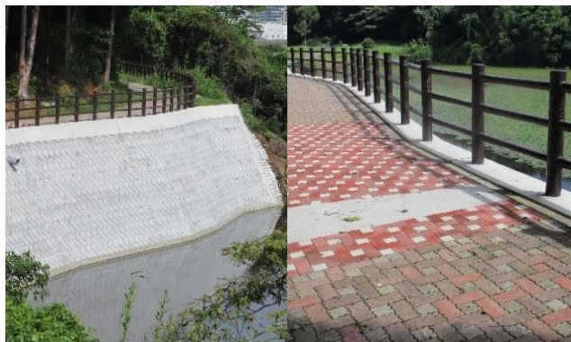
復旧工事実績(明天寺公園)
