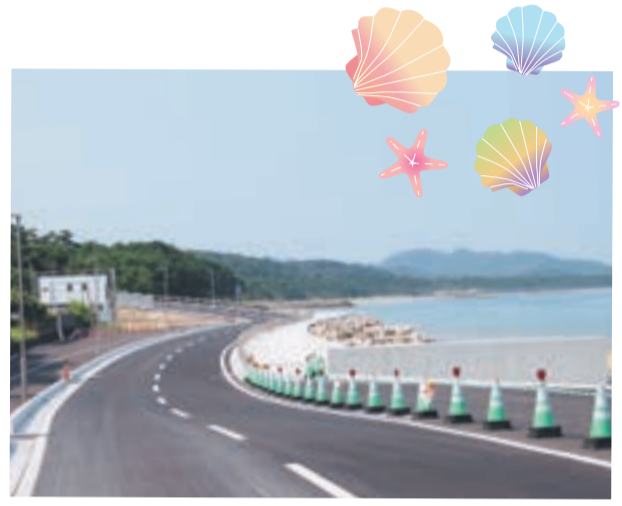
新しく完成した道路
